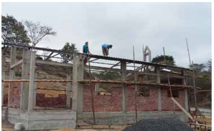
En Estero Seco se construyó una nueva capilla con mucho esfuerzo. Esta capilla representa el apoyo ofrecido a las comunidades del campo
